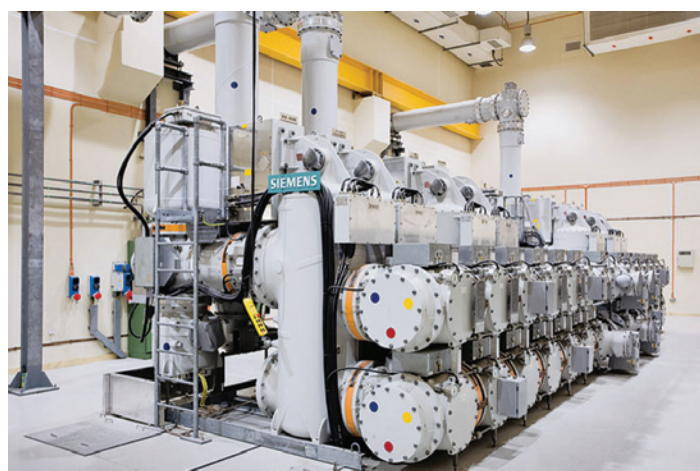
Figura 2. GIS para montagem interior.
