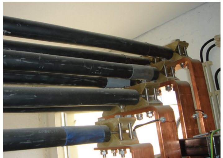
Figura 2. Posto de Transformação. (Utilização de dois condutores por fase na alimentação do QGBT). (Dois cabos monocondutores em paralelo em cada fase).
