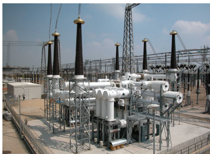
Figura 3. GIS para montagem exterior.
