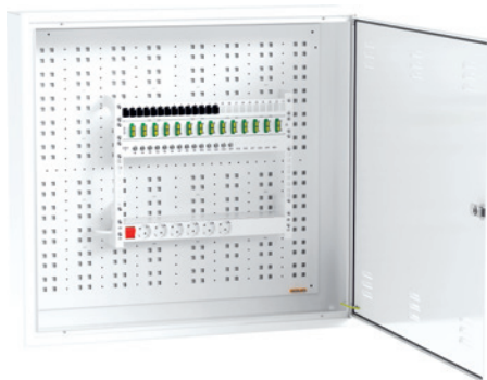
Figura 1. ATE equipado com Repartidores Gerais.
