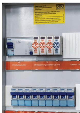
Figura 1. Descarregador combinado tipo 1+2, V50 3+NPE-280, no quadro principal.
