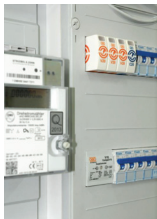
Figura 2. Descarregador de sobretensões tipo 2, V20 3+NPE-280, no quadro parcial.
